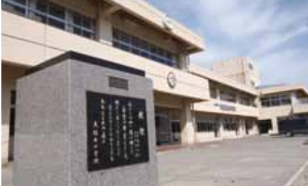
1階が津波で浸水した大槌北小学校。この2階を宿泊施設として整備した。
