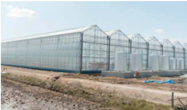
山元町山寺で建設が進む最先端大規模園芸施設(4月初旬)
