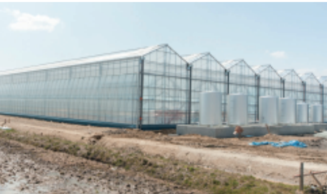
山元町山寺で建設が進む最先端大規模園芸施設(4月初旬)
