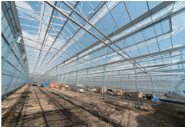
大規模先端園芸施設の内部（完成前）
