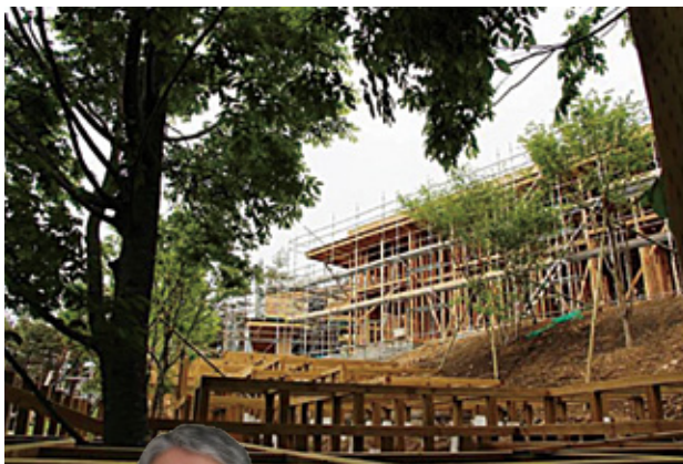
研修や催し、宿泊できる施設「箱根山テラス」。9月のオープンに向け建設が進む様子は、専用のフェイスブックページでもアップしている。
