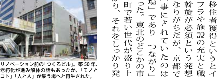
リノベーション前の「つくるビル」。築50年、老朽化が進み解体の話もあったが、「モノとコト」「人と人」が集う場へと再生された。
