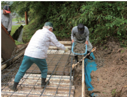
目下、学校の裏に五右衛門風呂を作るため、コンクリートの橋をかける工事が「どぼく学部」を中心に行われている。
